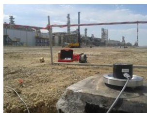
Установка датчика в позицию 3
