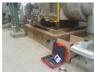
Установка датчика в позицию 1
